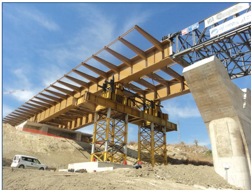
Ultimazione della terza fase di spinta
