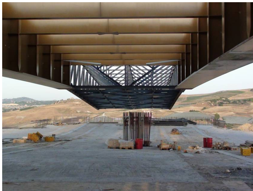
Impalcato metallico con avambecco in direzione delle pile
