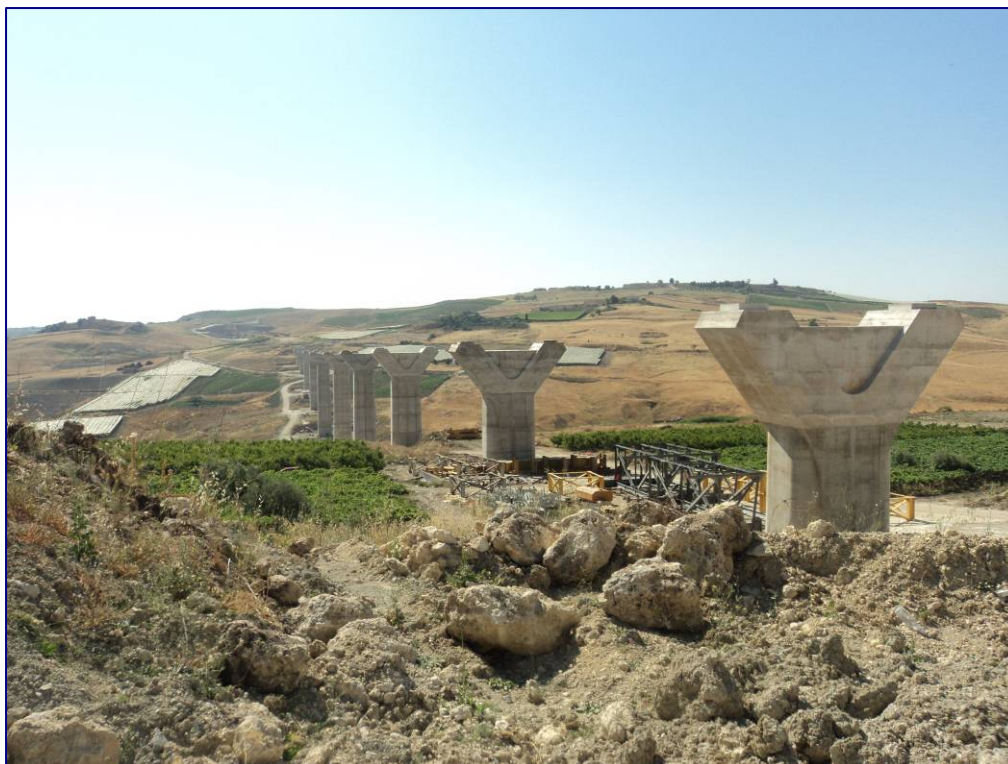
Vista generale delle pile in attesa dell'impalcato
